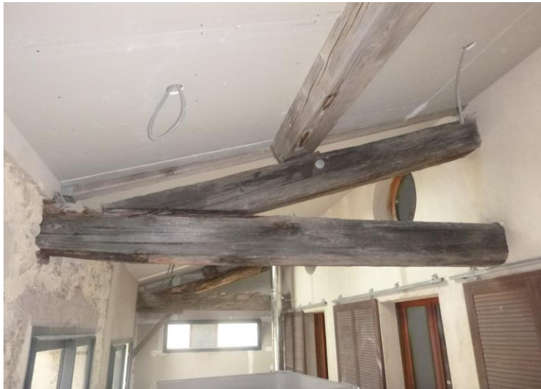
Découpe des parties à remplacer
