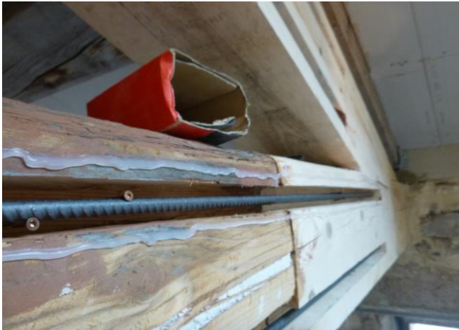
Preparation et ajustement des coupes saignées / broches / calages
