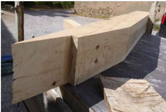
Preparation et ajustement des coupes saignées / broches / calages
