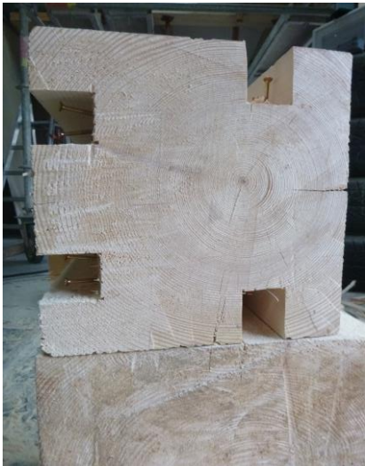
Preparation et ajustement des coupes saignées / broches / calages
